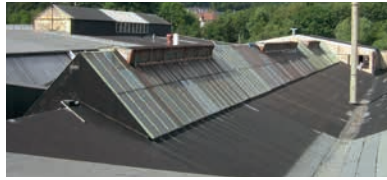
Drahtglas-Sattellichtband vor der Sanierung
