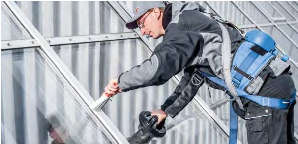
Reinigung von Schmutzablagerungen zur Sicherstellung des korrekten Wasserablaufs (keine Glasreinigung)
