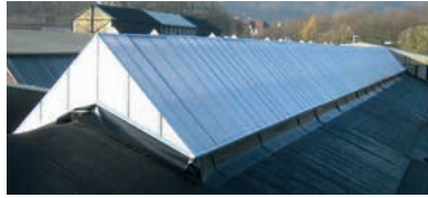
Sattellichtband nach der Sanierung
