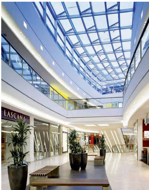
VENTRIA TG eingebaut als Lüftungsflügel im Flachdach
