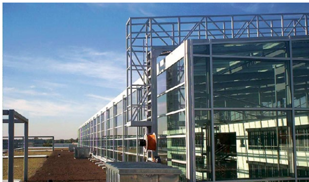
Einsatz einer Befahranlage
